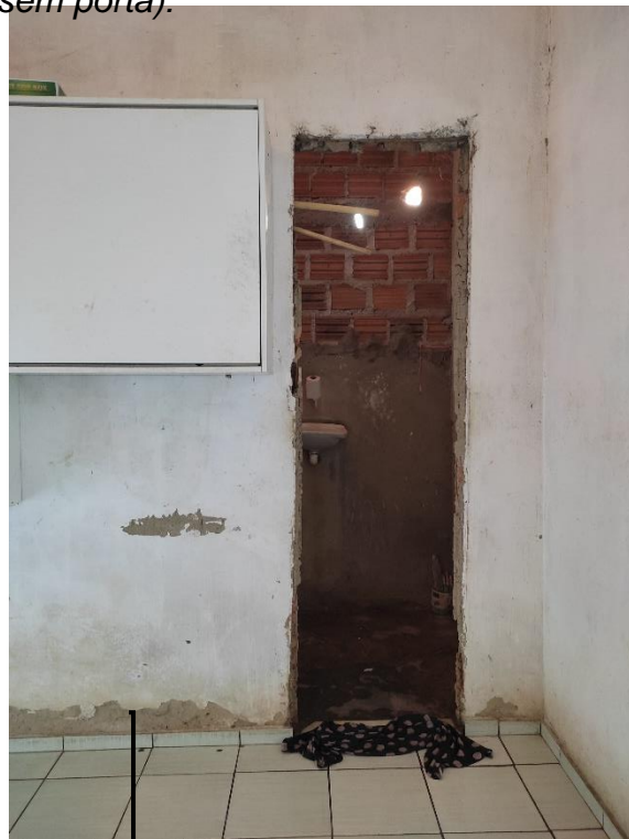
Reboco descascando
